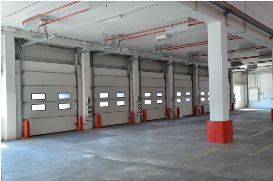
Beispiel Rampentore mit Überladebrücken
