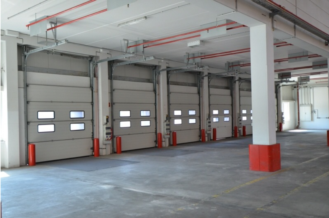
Beispiel Rampentore mit Überladebrücken
