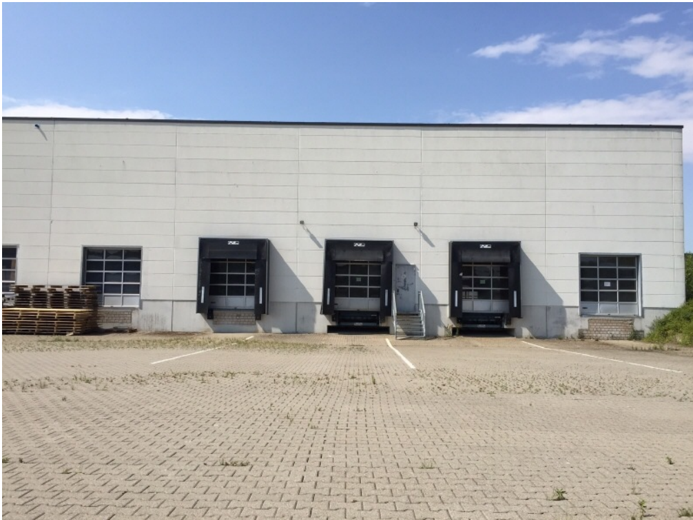
Beispiel von Außen
