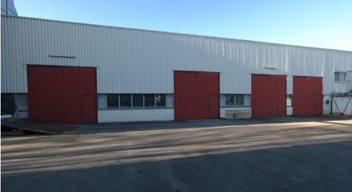
Außenansicht (ebenerdige Tore)
